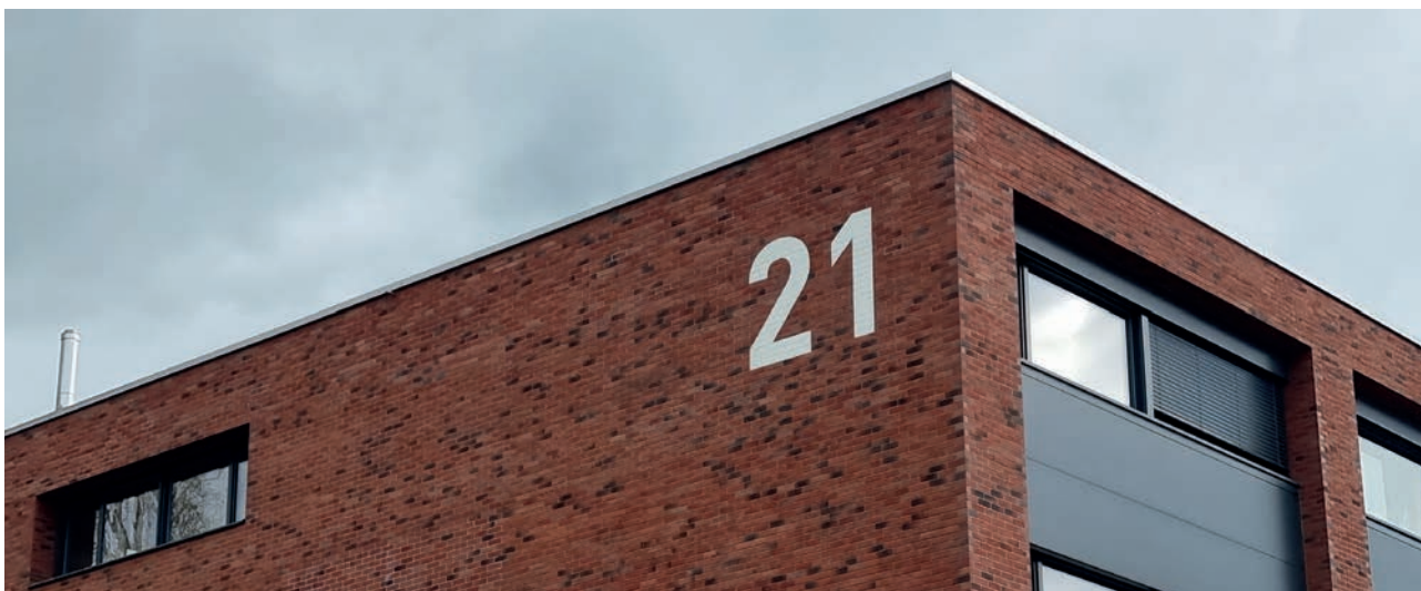
Halle artisanale chemin des Epinglis 21
